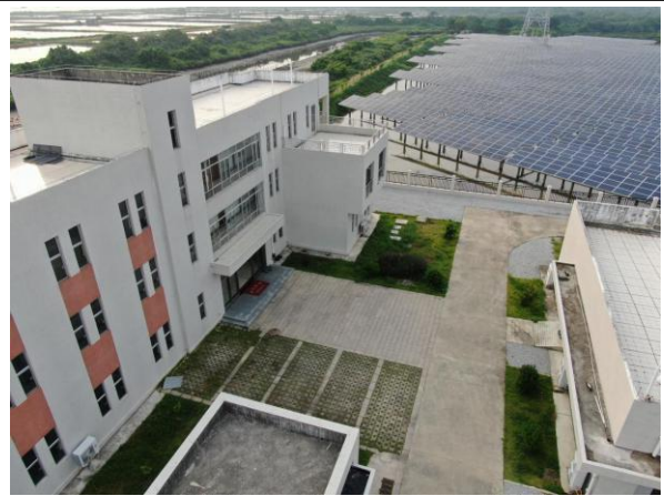
位置：升压站 现场：升压站站内绿化区域实施植草防护，防护效果较好
