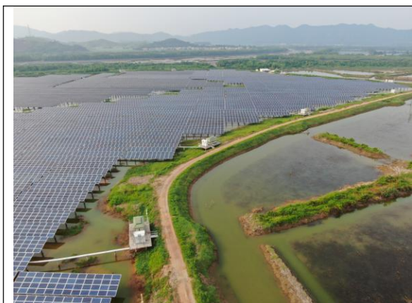
位置：检修道路 现场：检修道路两侧土路肩及填筑边坡实施植被恢复措施，路面采用碎石路面
