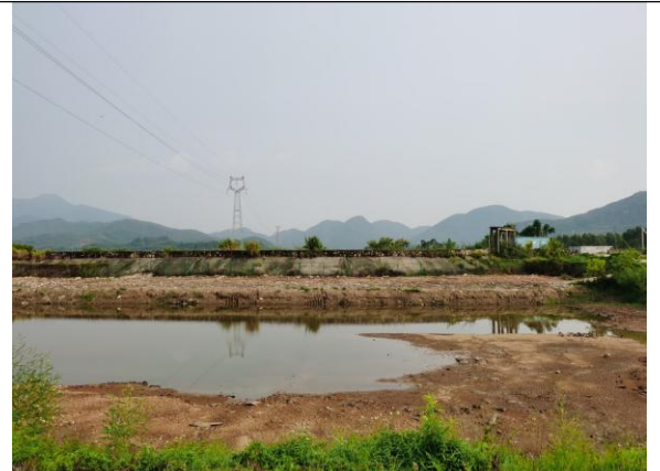
位置：施工生产生活区 现场：施工生产生活区已经拆除，场地平整恢复养殖水面
