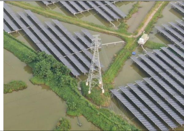
位置：集电线路 4#塔 现场：塔基平台完成植被恢复措施
