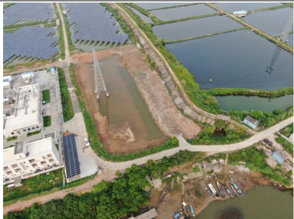
位置：施工生产生活区 现场：施工生产生活区已经拆除，场地平整恢复养殖水面
