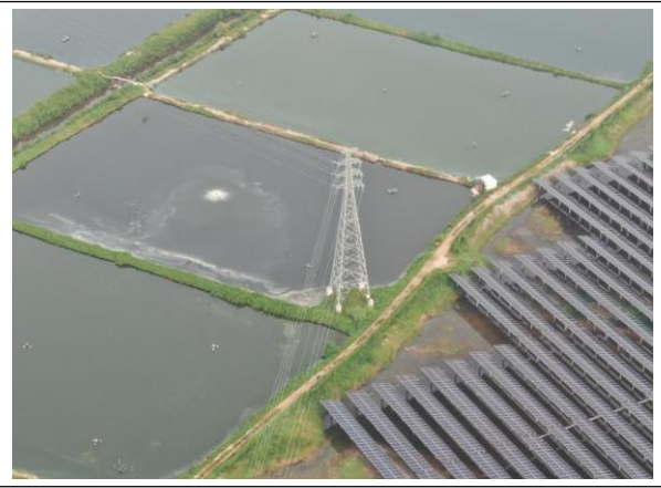
位置：集电线路 2#塔 现场：塔基平台完成植被恢复措施
