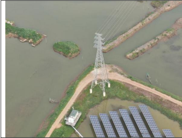
位置：集电线路 1#塔 现场：塔基平台完成植被恢复措施
