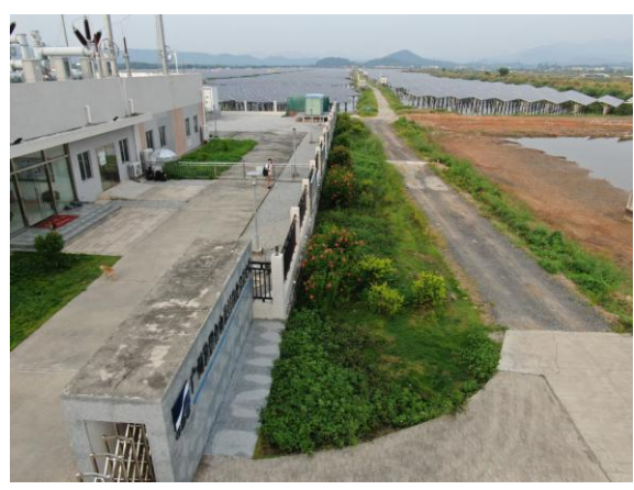
位置：升压站 现场：升压站站外绿化区域实施植草防护，防护效果较好
