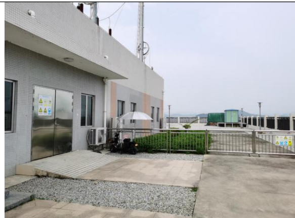
位置：升压站 现场：升压站站外绿化区域实施植草防护，防护效果较好
