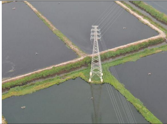
位置：集电线路 3#塔 现场：塔基平台完成植被恢复措施
