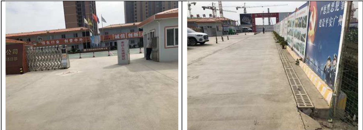
项目部板房（2018年12月）
