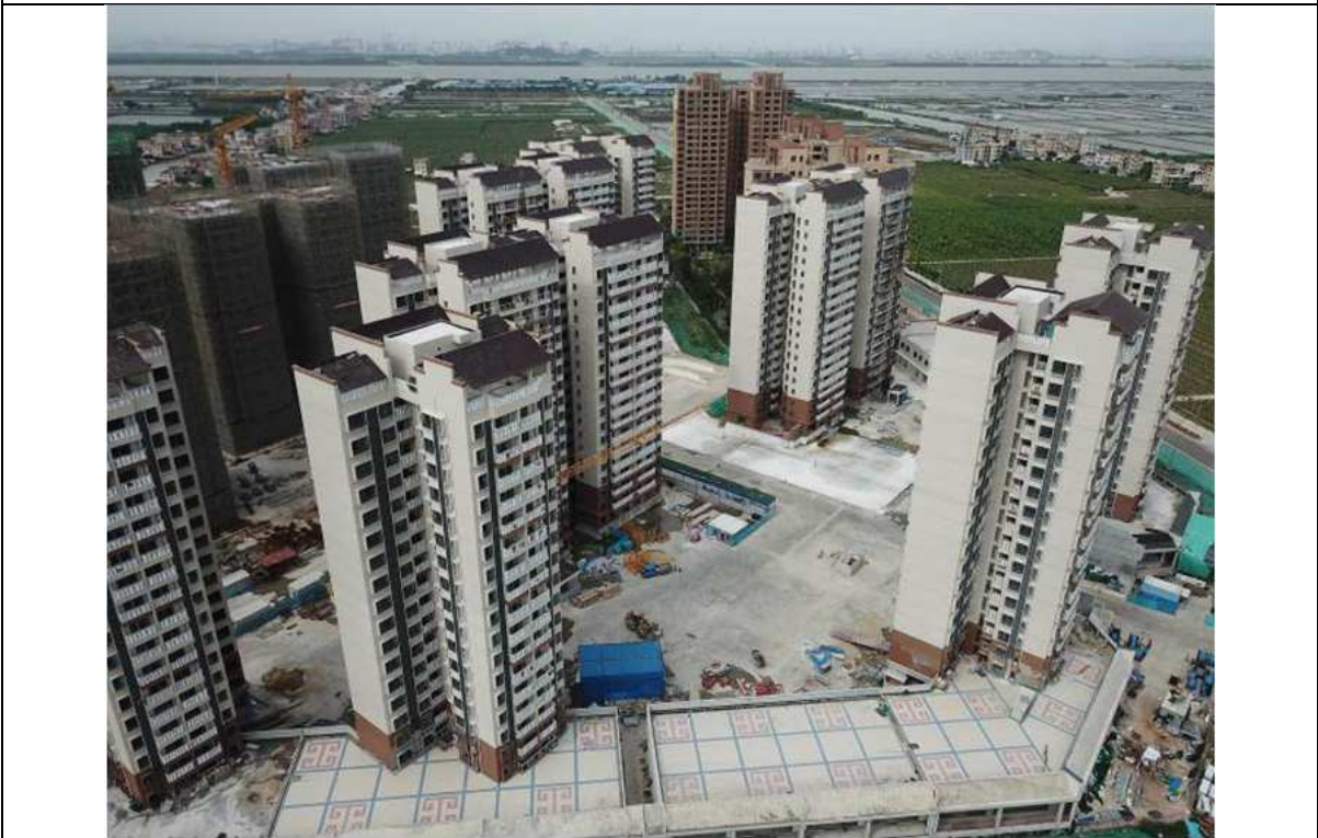
项目区基本完成硬化（2020年3月）
