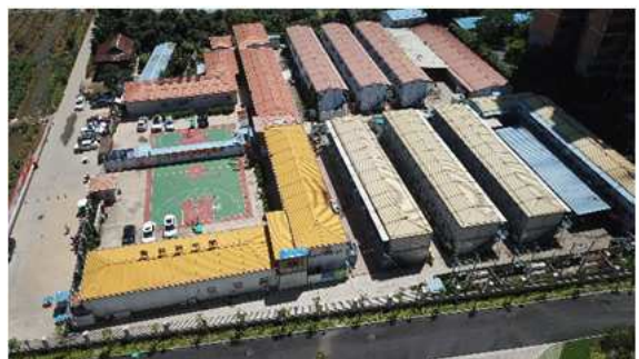
项目区临时板房 (2021.06 摄)
