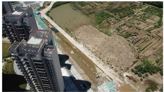
项目区西南侧市政道路施工 (2021.06 摄)
