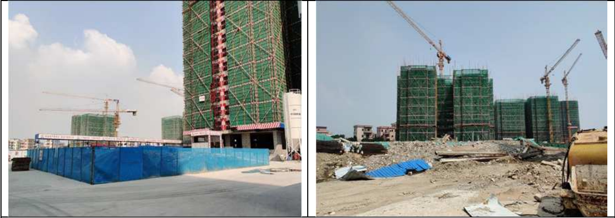
主体建筑施工（2019年9月）
