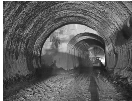
折线型辅助导洞施工现场
