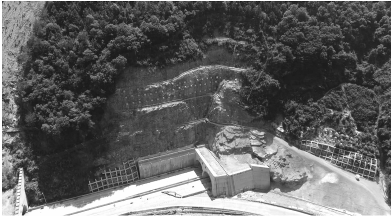
进口连拱端高陡边坡进洞洞门图
