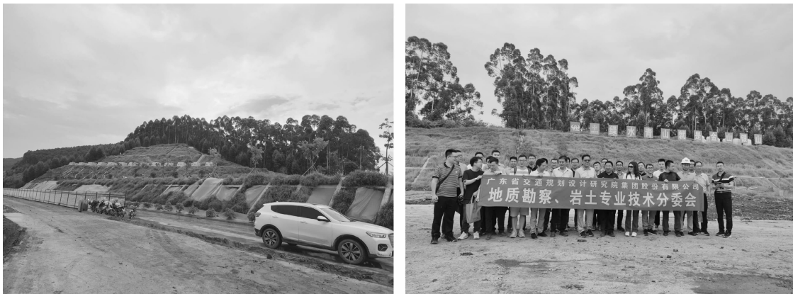
照片 3-4 K15 + 795 ~ K15 + 980 煤系地层边坡
