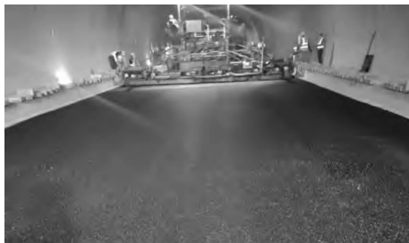
图2 阻燃沥青路面试验路施工
