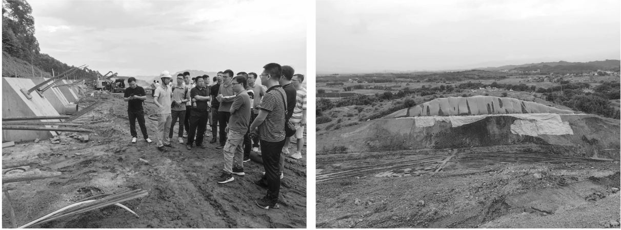
照片 5-6 K17 + 200 ~ K17 + 535 煤系地层边坡
