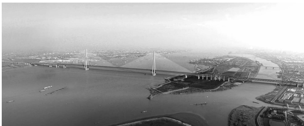
常泰长江大桥
