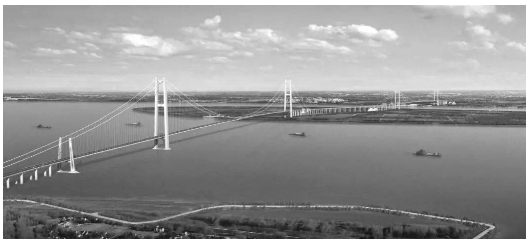
张靖皋长江大桥
