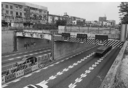
广明高速祈福隧道
